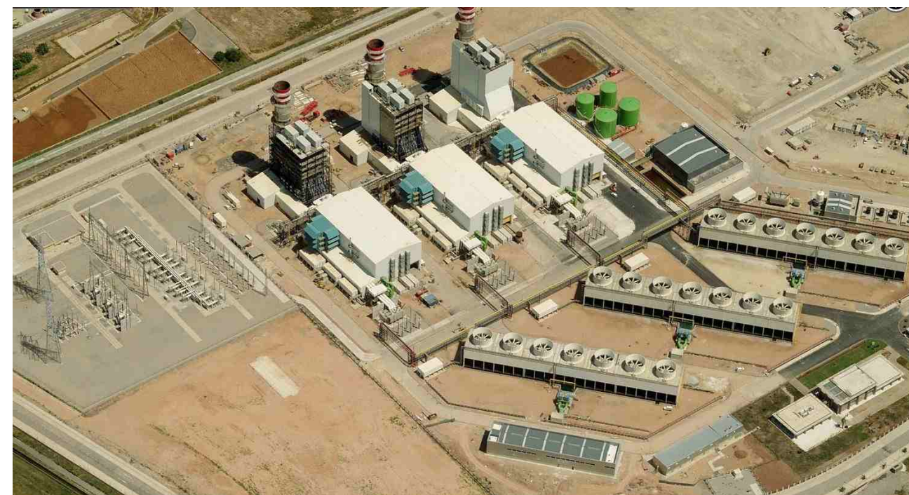
Foto: Subestación Eléctrica MORVEDRE, y Central de Ciclo Combinado UNION FENOSA
