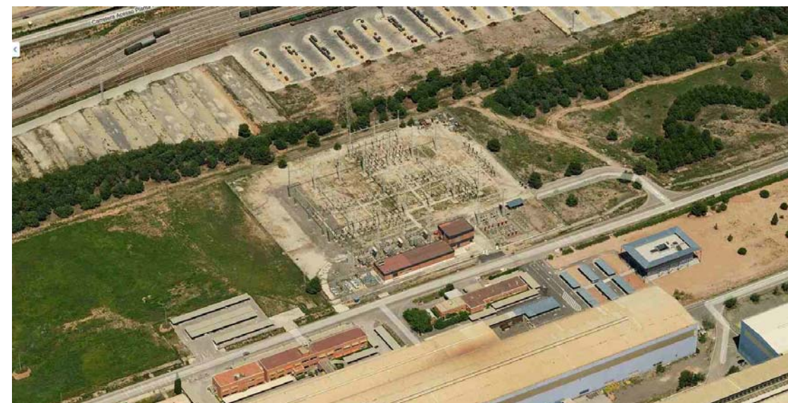
Foto: Subestación Eléctrica SIDMED (Bing Maps)
